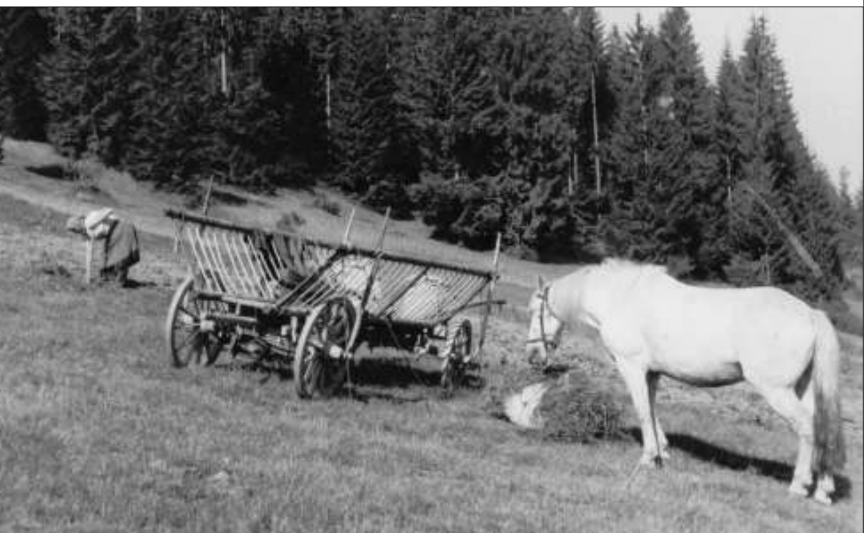
Vykopávanie zemiakov. Beňadovo. Foto J. Čaplovič, prvá polovica 20. storočia
